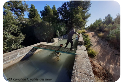
ASA Canal de la vallée des Baux
