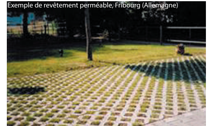
Exemple de revêtement perméable, Fribourg (Allemagne)
